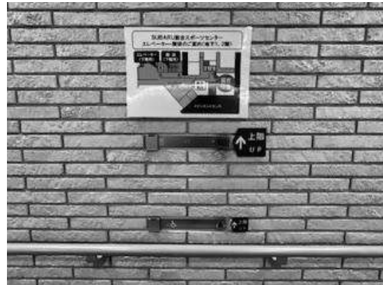
写真 21 ボタンが小さく、カバーがある エレベーターボタン
