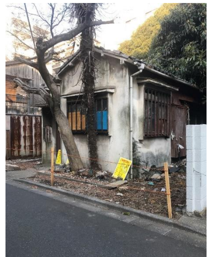
写真⑥ 空き家ゴミブロック塀撤去後
