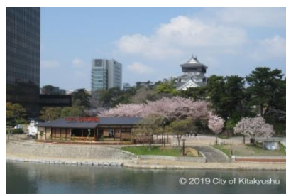
対岸からの施設全景
