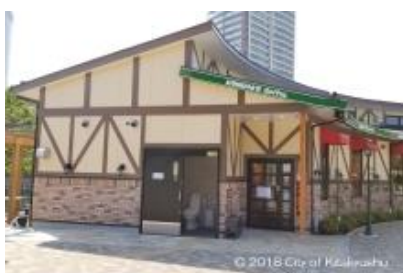
多目的便所 (公募対象公園施設)
