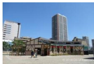
便益施設全景 (広場方向より)
